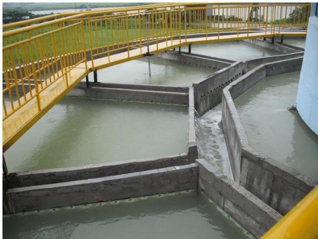
上流固体接触式澄清池(软化)
