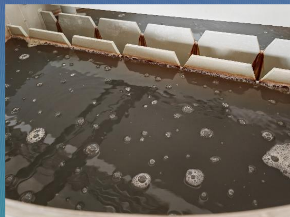
出水液面产气情况
