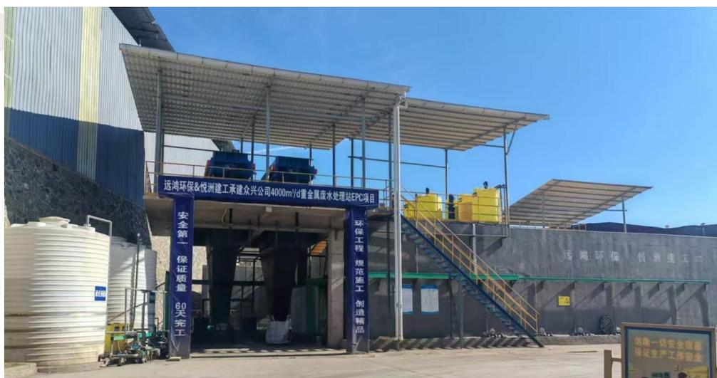
3.2重庆吉恩冶炼有限公司（300立方米生产废水除铊除重金属废水处理站总包）总包建设了一套300m<sup>3</sup>/d废水除镍、铊、镉、砷、铬等重金属及除磷、氨氮的废水处理站和一套20m<sup>3</sup>/d的生活废水处理设施，处理厂区内的生产废水和生活废水，外排工业废水执行《铜、镍、钴工业污染物排放标准》（GB25467-2010）表2规定的企业水污染物排放浓度限值，总铊执行《工业废水铊污染物排放标准》（DB43/968-2021）排放限值，外排生活污水执行《污水综合排放标准》（GB8978-1996）一级标准，确保全面处置达标。
