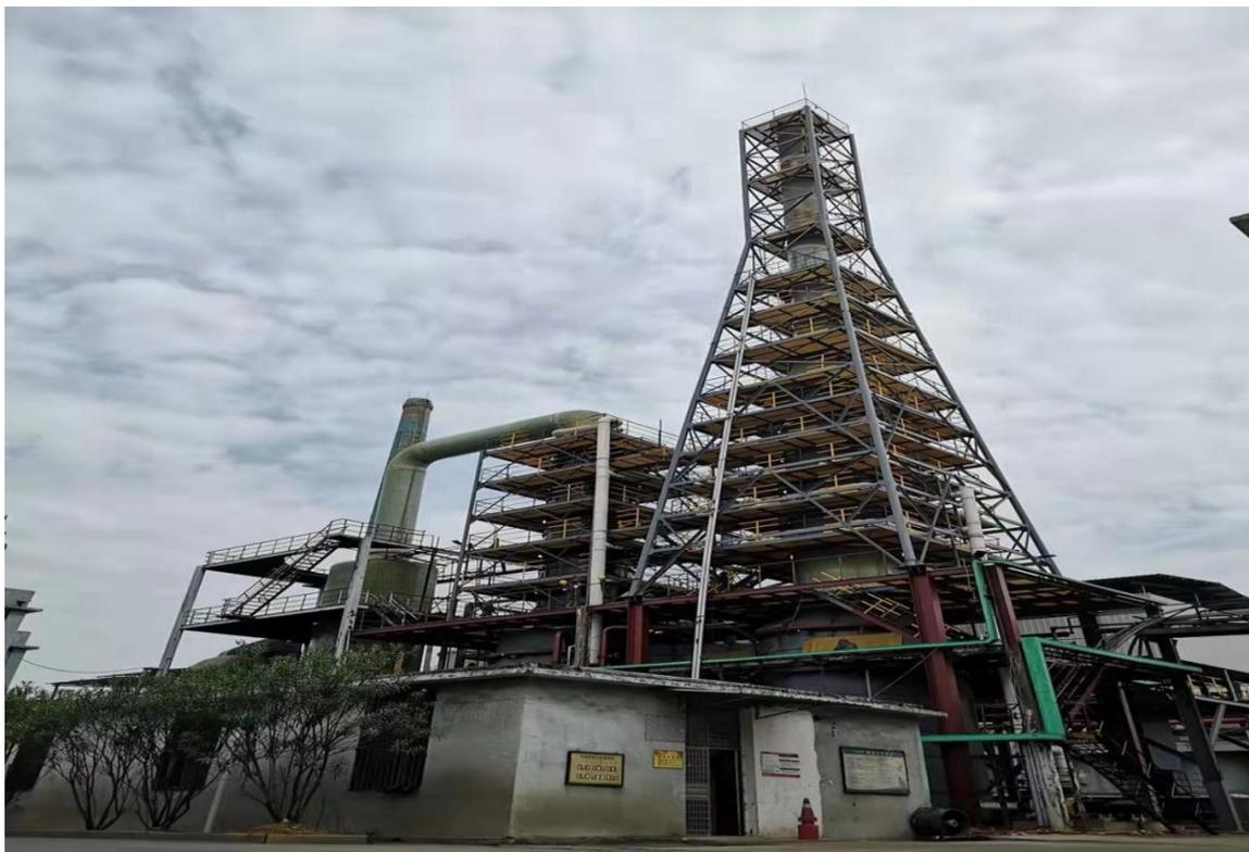
郴州丰越环保科技有限公司富氧侧吹三联炉尾气脱硫脱硝除尘塔（20万m<sup>3</sup>/h）
