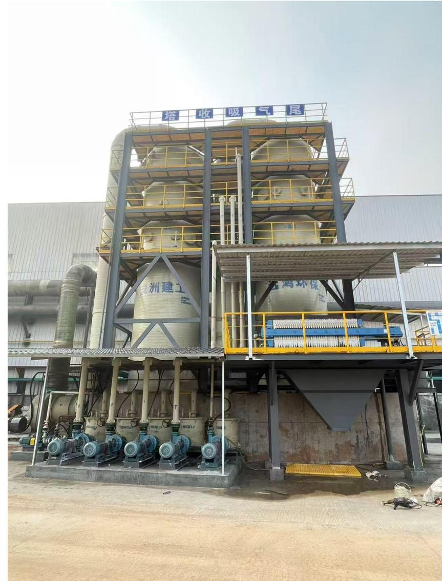
郴州丰越环保科技有限公司回转窑尾气脱硫脱硝除尘塔（10万m<sup>3</sup>/h）
