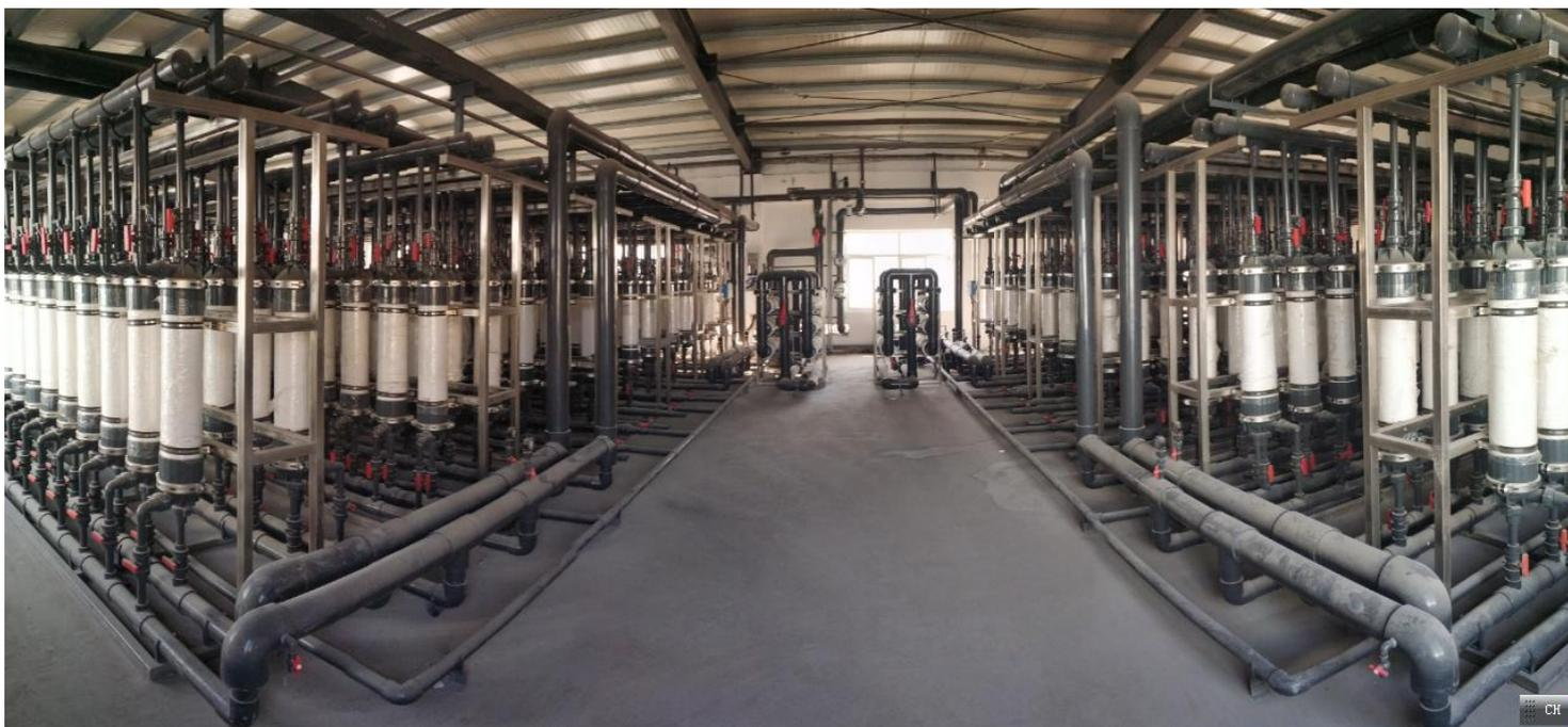
废水：氨氮 $\leq 1000\text{mg/L}$ ，氰根 $\leq 20\text{mg/L}$ ， $2440\text{m}^3/\text{d}$
