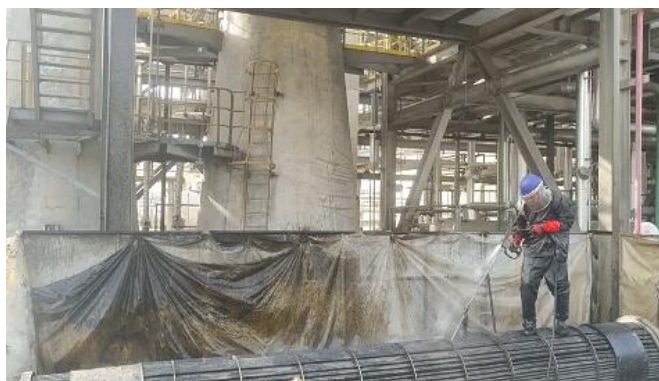
蒸氨脱酚换热器、塔盘、管路污堵
