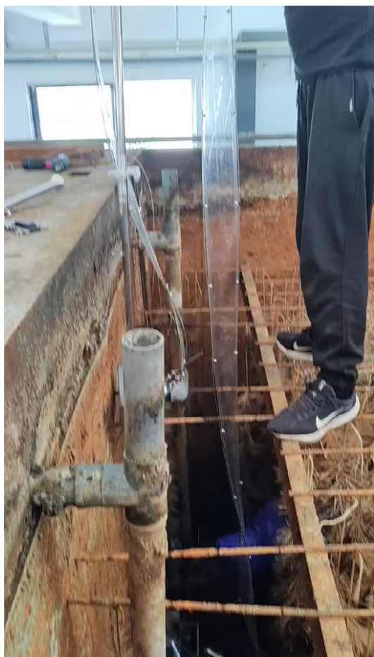
悬拉式曝气器安装过程
