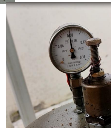
采用回转式风机，曝气量大幅增加情况下，系统压力仍降低5%。
