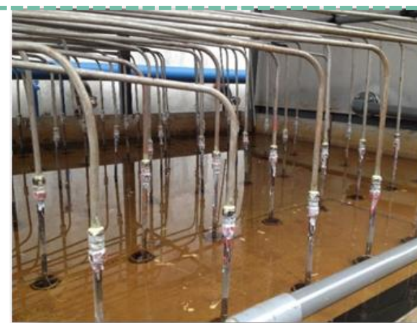
*实物运行照片
