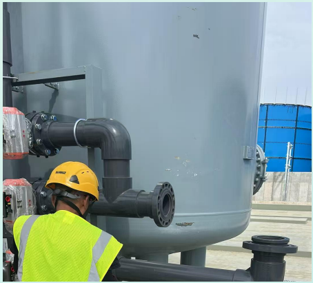
美国项目现场安装
