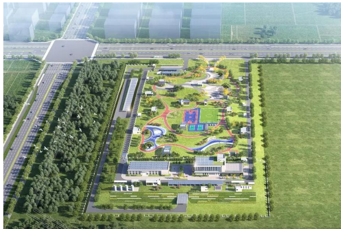
新站高新区综合水质净化工程
