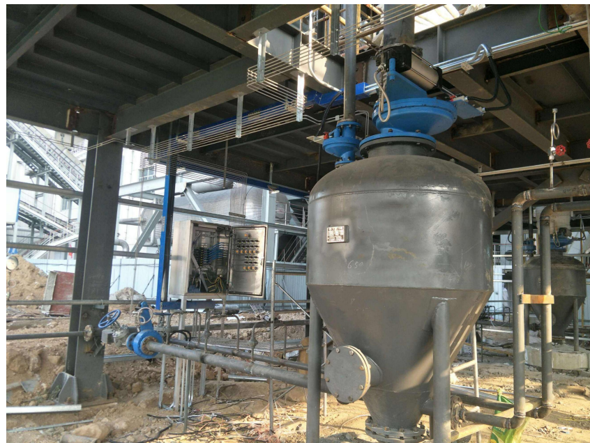
某电厂脱硫废水旁路烟气蒸发项目
